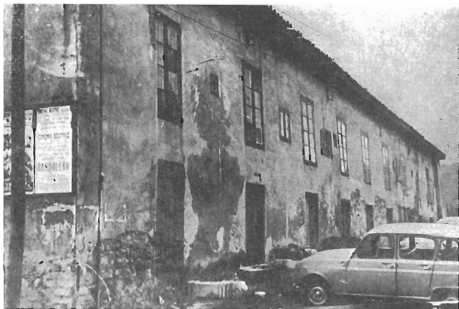
Edificio desaparecido del «Colegio Cántabro» en El Astillero de Guarnizo (foto Archivo del Ayuntamiento de El Astillero).
