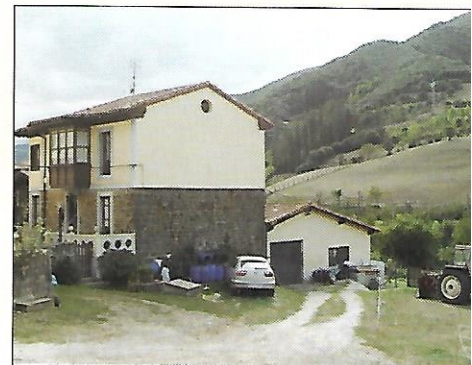
Carpintería Goyo Bores.
