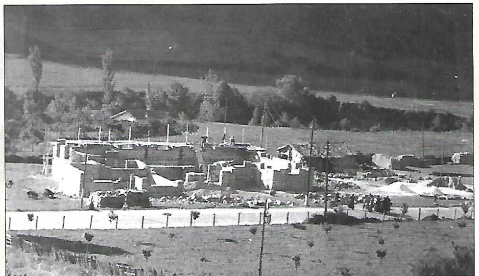
Iglesia de Ojedo en construcción.
