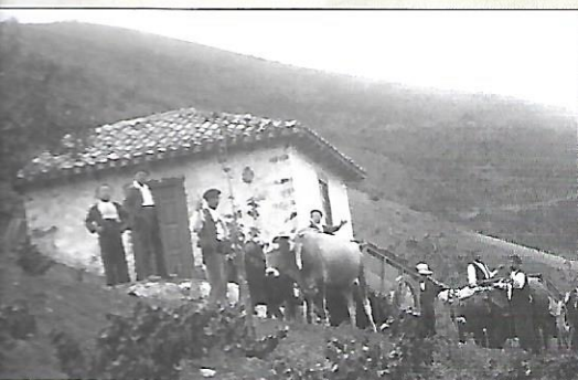
Vendimiando en Sierratama.
