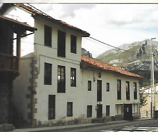
Casa y bodega de D. Victoriano Almirante.
