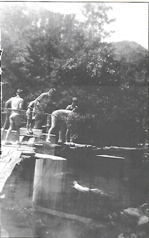
Puente de Campañana en construcción.
